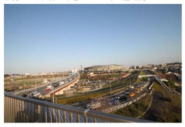
㎡ (約900m四方)の土地を、高さ 5 メートル程度の土手で囲ったプール状区域を作り、大雨時は川に流れる水を一時的に最大 3,900,000 トン(前述の横浜市の1日の下水処理量が1,600,000トン) 貯留させておくことで、川が溢れるのを防ぐそうです。
