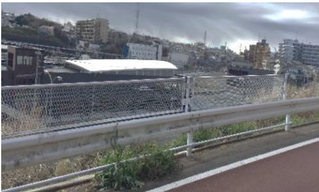
羽沢横浜国大駅新設時出来た防止柵
